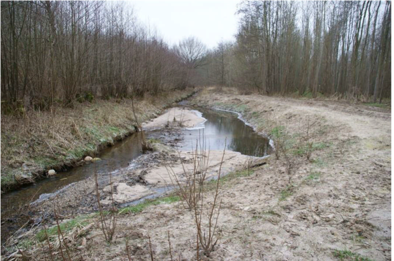
ABBILDUNG 23: SANDFANG AN DER OHLAU (SCHLESWIG-HOLSTEIN) (GEWÄSSERPFLEGEVERBAND OHLAU 2014)
