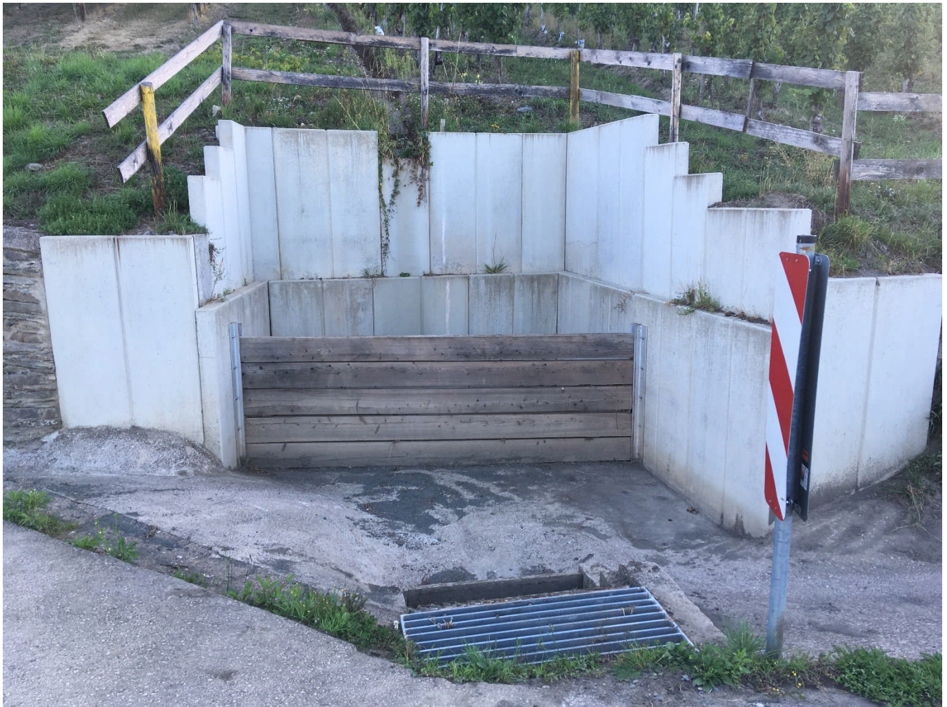
ABBILDUNG 22: SANDFANG EINES ABLEITUNGSGRABENS IN WALDRACH (FOTO INCA, 2021)
